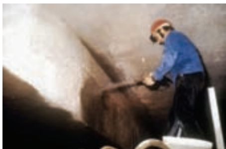
Rys. 2.6. Naprawa elementów torkretowaniem (natryskiwaniem betonu) (Dzięki uprzejmości DBV, Niemcy)
