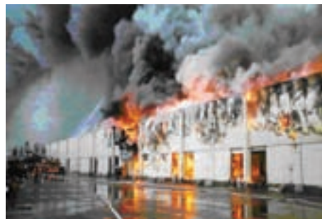
Rys. 5.1. Lekkie ściany warstwowe z blaszaną obudową zawiodły w tym pożarze rzeźni w Bordeaux (Francja), w styczniu 1997 r. Pożar objął cały budynek i zajął przyległe budynki. (Dzięki uprzejmości SDIS 33, Straży Pożarnej w Gironde, Francja)
