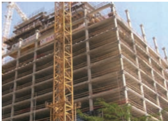
Rys. 1.3. Wieże North Galaxy Towers w Brukseli. Ten 30-piętrowy budynek z żelbetu spełnia bieżące surowe wymogi odporności ogniowej (REI 120); słupy wykonano z betonu wysokiej wytrzymałości C80/95. (Dzięki uprzejmości ER-GON, Belgium)
