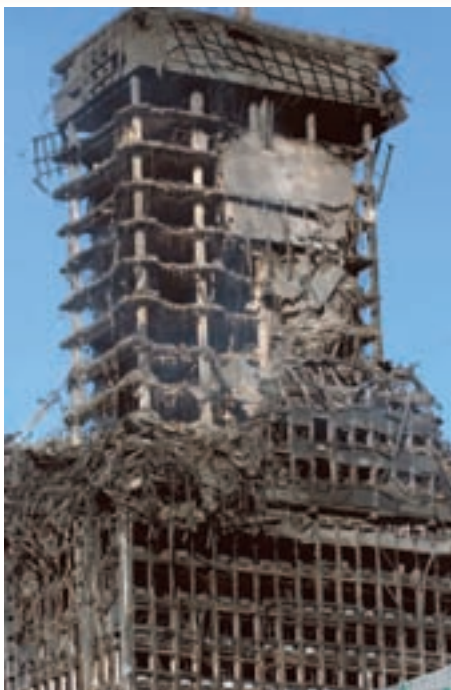
Rys. 4.2. Fasada ponad poziomem technicznym na piętrze 16 została zupełnie zniszczona. (Dzięki uprzejmości IECA, Hiszpania)
