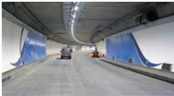
Rys. 1.4. Betonowe tunele i powierzchnie dróg wytrzymają ekstremalne warunki pożarowe panujące w tunelach. Tunel Cointe (połączenie E25-E40) w Liege, w Belgii, zastosowanie betonowej nawierzchni w celu zwiększenia bezpieczeństwa tunelu.
